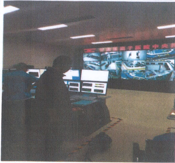
二楼中央控制室内检测
