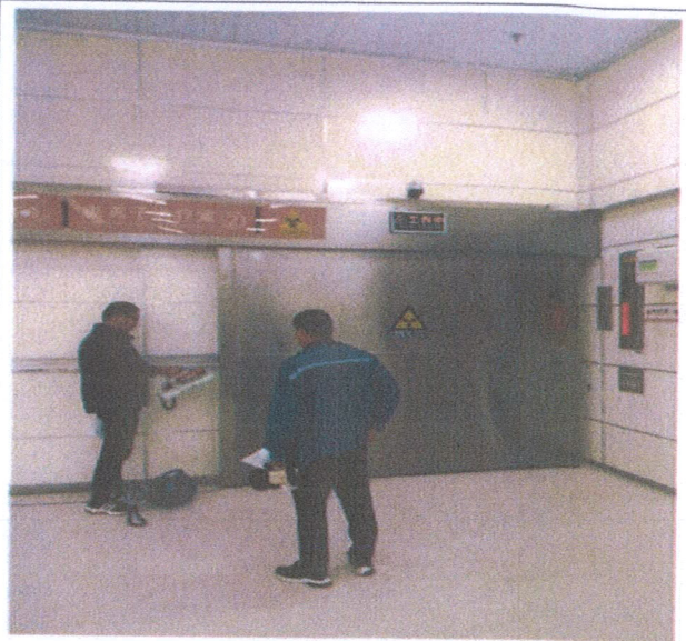
治疗室 2 防护门处检测
