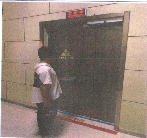
CT机房患者进出防护门中间门缝处
